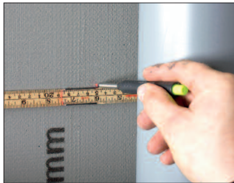
Ta mål og tilpass rørkassen i høyde.
