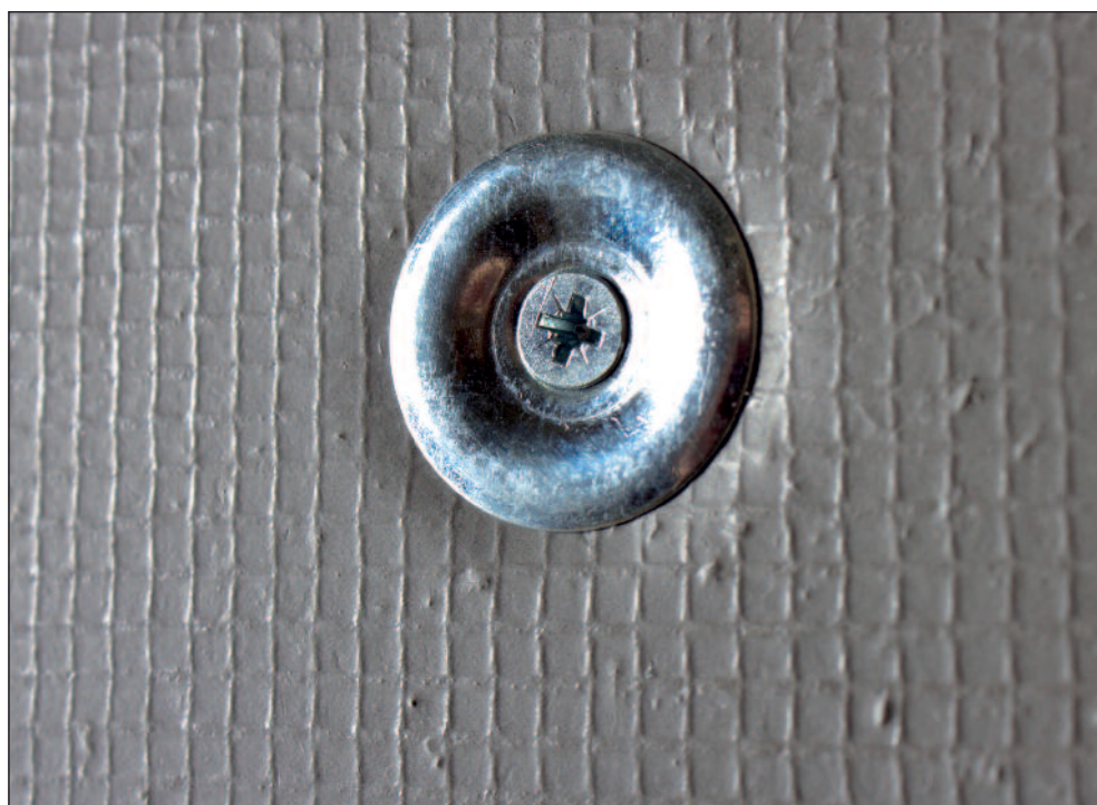
Monteringskiven skal ikke lage en forhøyning eller grop i platen.
