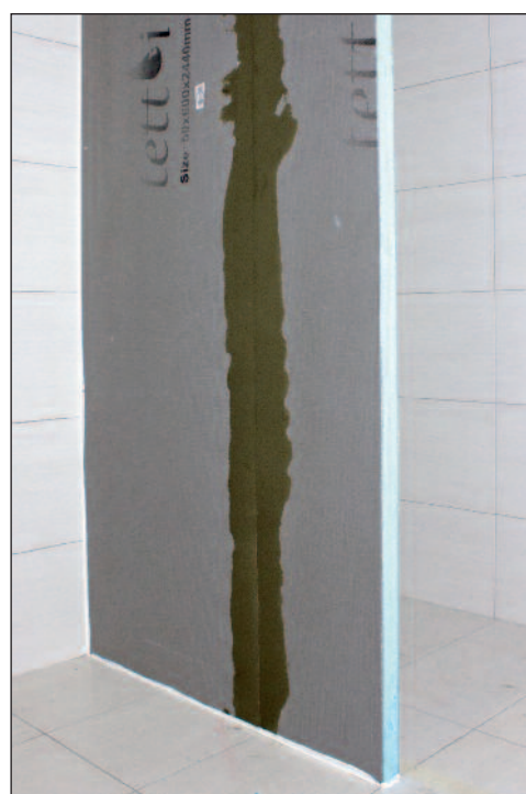
Dusjevegg klar for flislegging.
