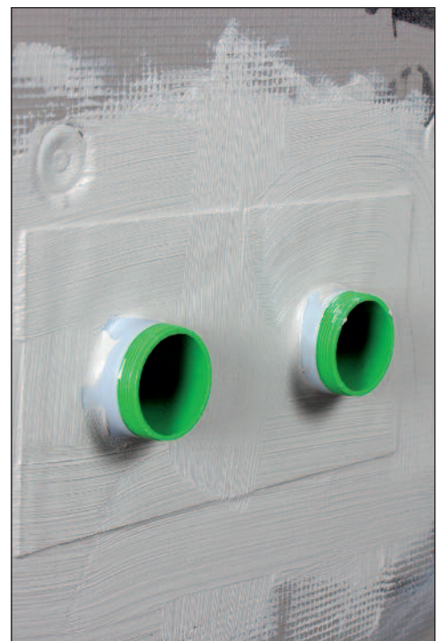
Påfør nye strøk med membran.
