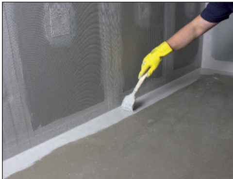
Påfør membran langs veggene med pensel.
