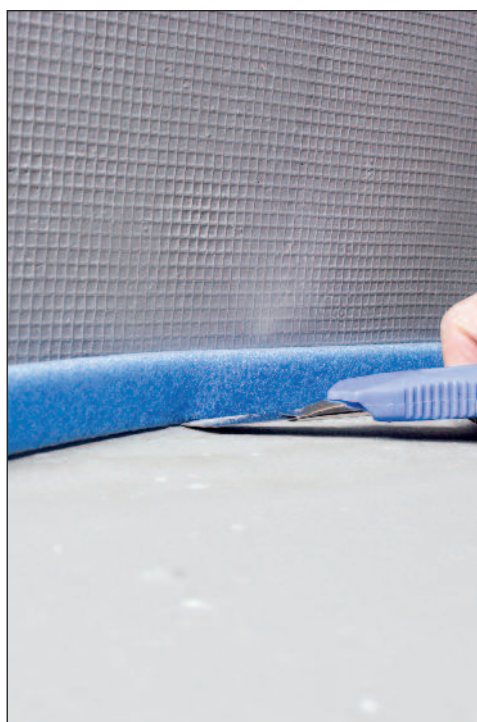
Overskytende ekspansjonsbånd fjernes.
