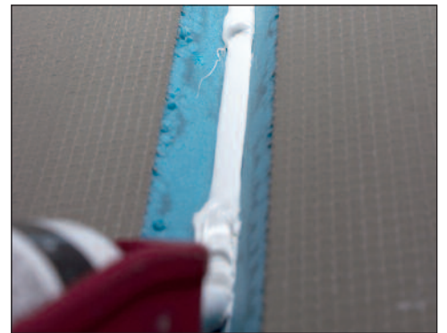
Påfør lim i rørkassens v-spor.
