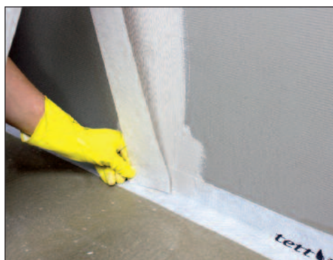
Legg fiberremsen i våt membran.
