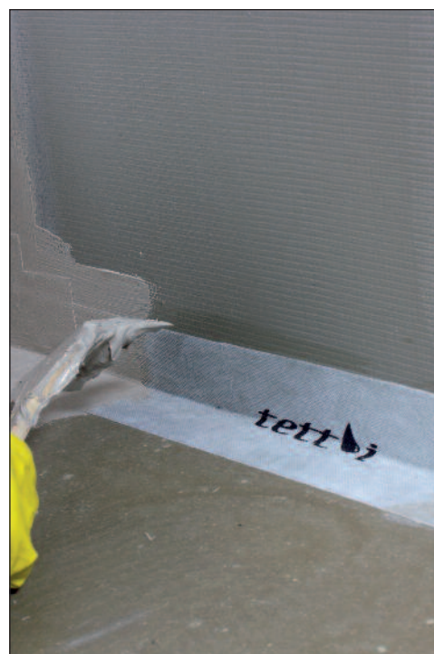
Selvklebende bånd dekkes med membran.
