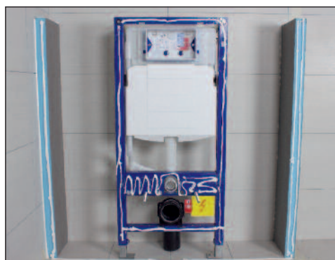
Påfør monteringslim på ramme og sidevegger.
