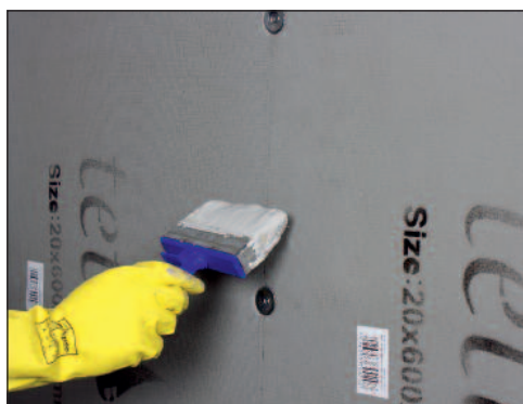
Påfør membran på hver side av plateskjøt.
