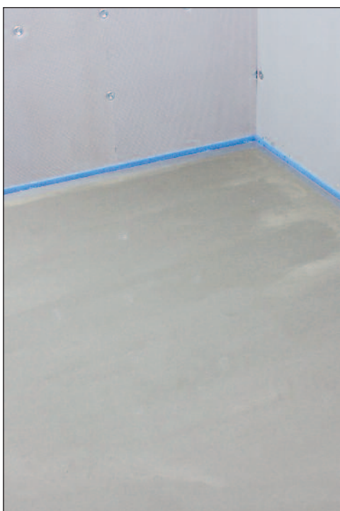
Ferdig avrettet gulv.
