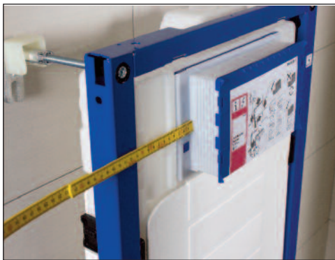
Ta mål og tilpass kassen.
