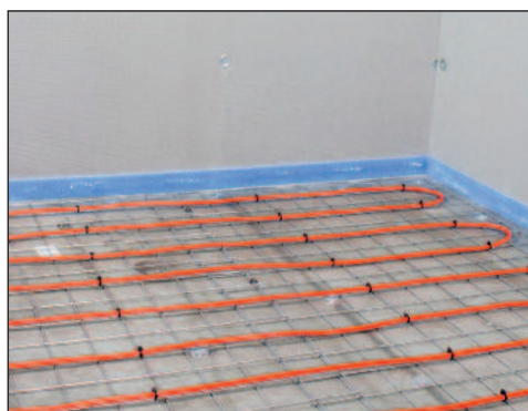
Benytt armeringsnett når dette er påkrevd.
