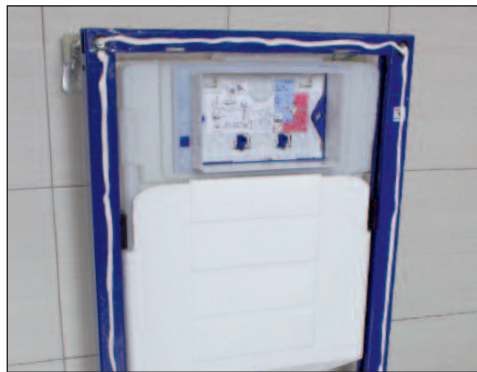
Påfør monteringslim på ramme, vegg og gulv.
