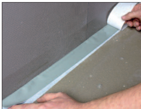
Båndets dekkpapir er todelt - enkel montering.
