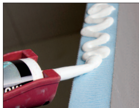
Påfør tilstrekkelig med Tetti monteringslim.
