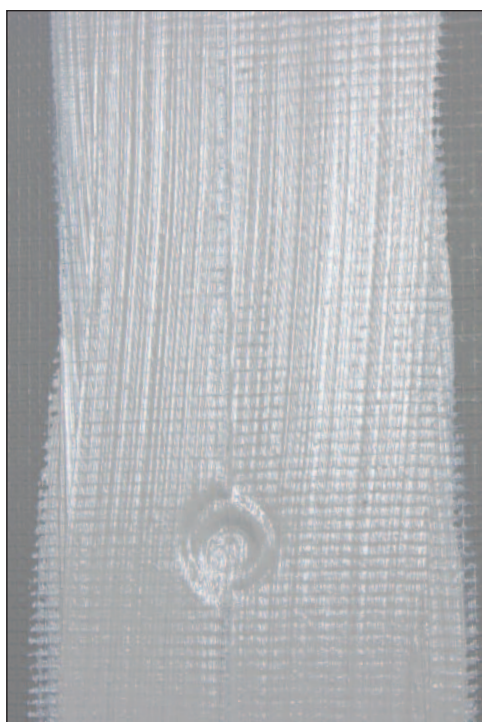
Påfør nye strøk med membran.
