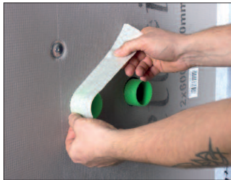
Bruk maskeringstape for å unngå søl på røret.
