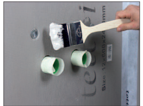
Påfør membran i et tilstrekkelig stort område.
