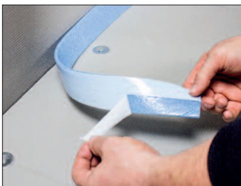
Benytt ekspansjonsbånd langs alle vegger.
