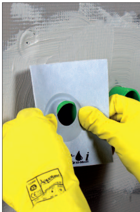
Tre mansjetten forsiktig på røret.
